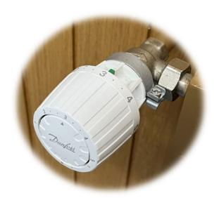
Pour le réglage figurent des symboles et des chiffres qui vont généralement de 1 à 5. En tournant le robinet sur la bonne position, vous pouvez choisir la température adaptée à la pièce de votre logement. Grâce à l'automatisme de la vanne, la température choisie va rester constante.
